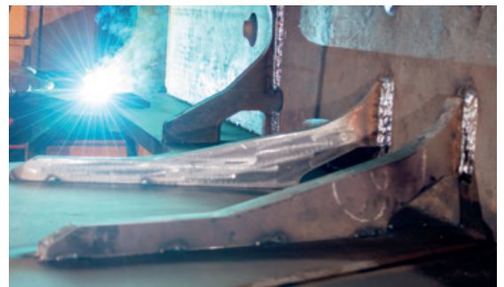
Exzellente Nahtoberfläche, tiefer Einbrand: mit nur einer Lage optimal verschweißter Querträger
